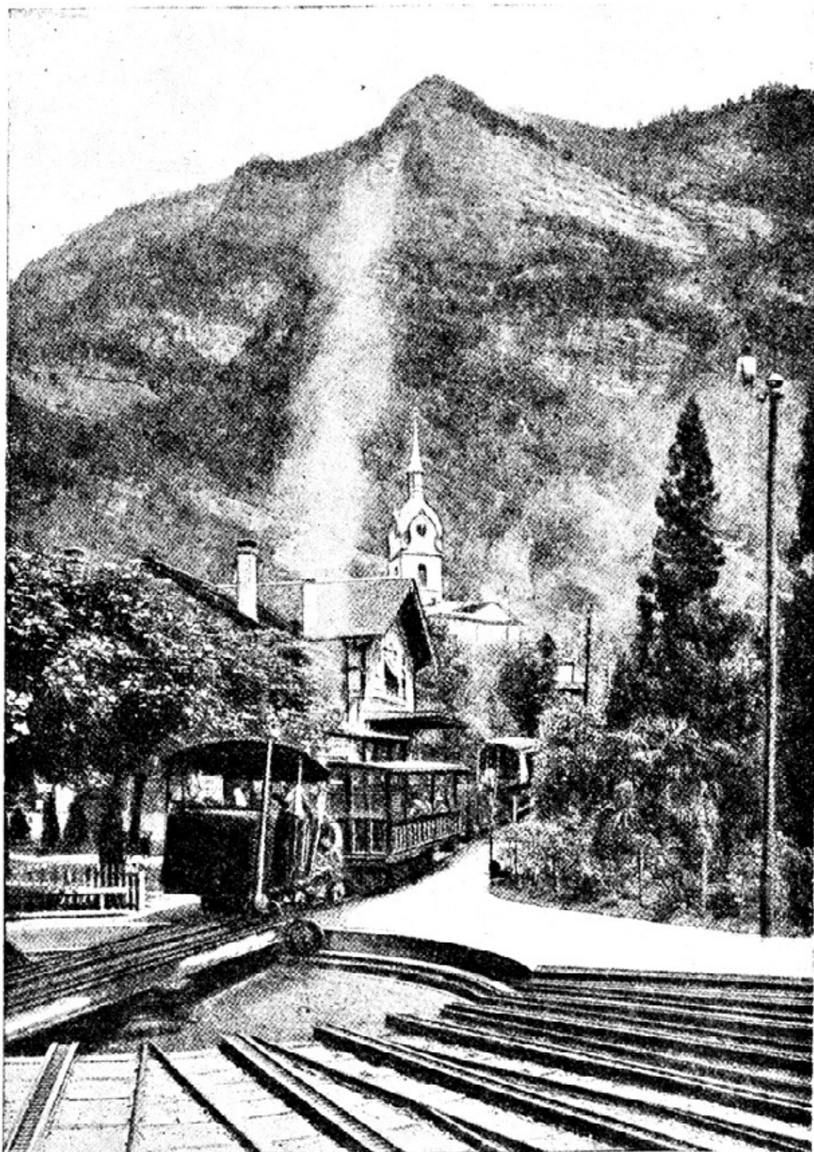
Фиг. 232. Станция Вицнау горной дороги на Риги. На переднем плане поворотный круг, поломка одного из зубцов того или другого из трех колес, так как если бы какая-нибудь часть одного из них оказалась сделанной из недоброкачественного материала, то это вряд
