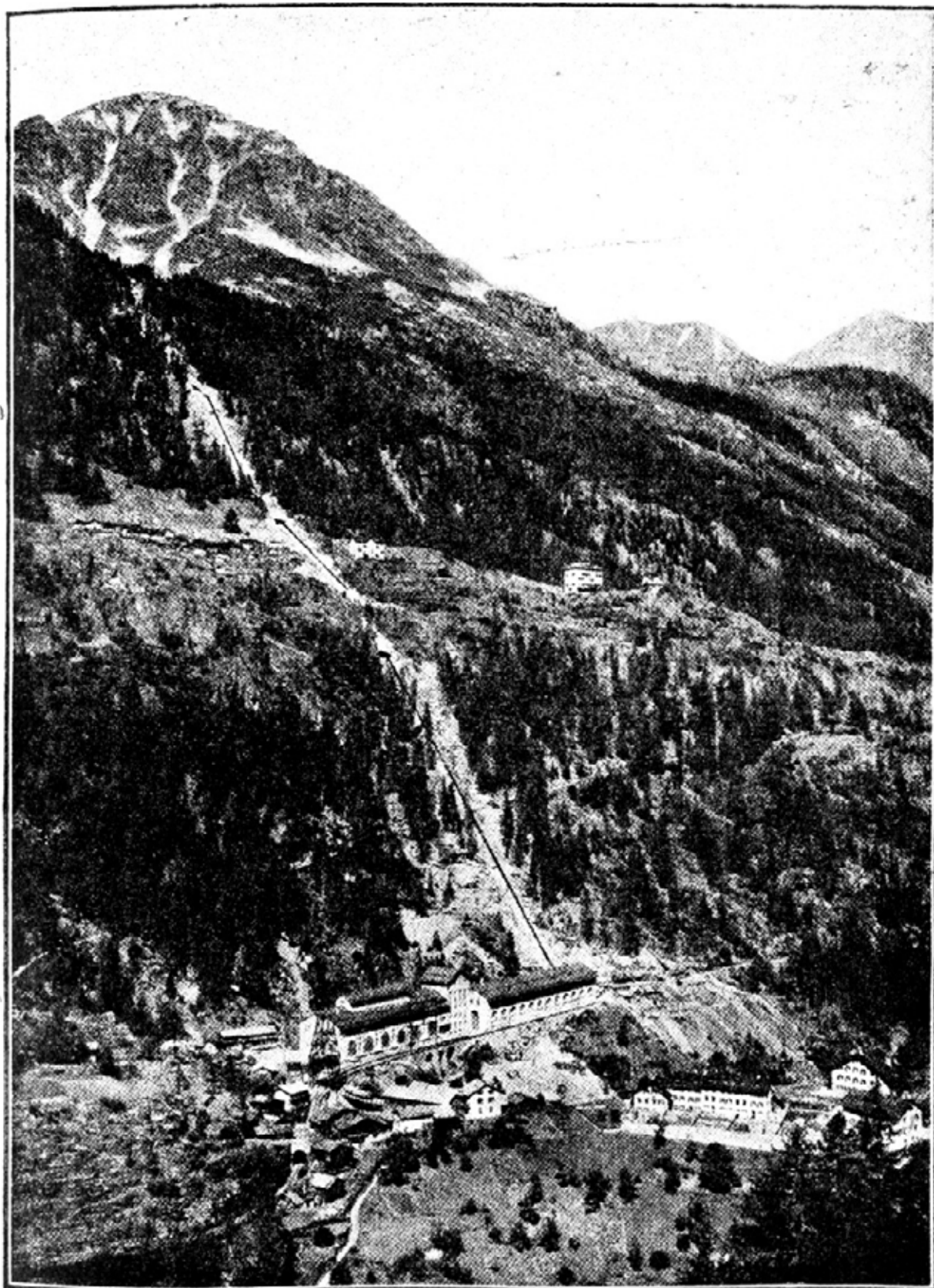
Фиг. 204. Электрическая станция швейцарских дорог „Барберина“.
