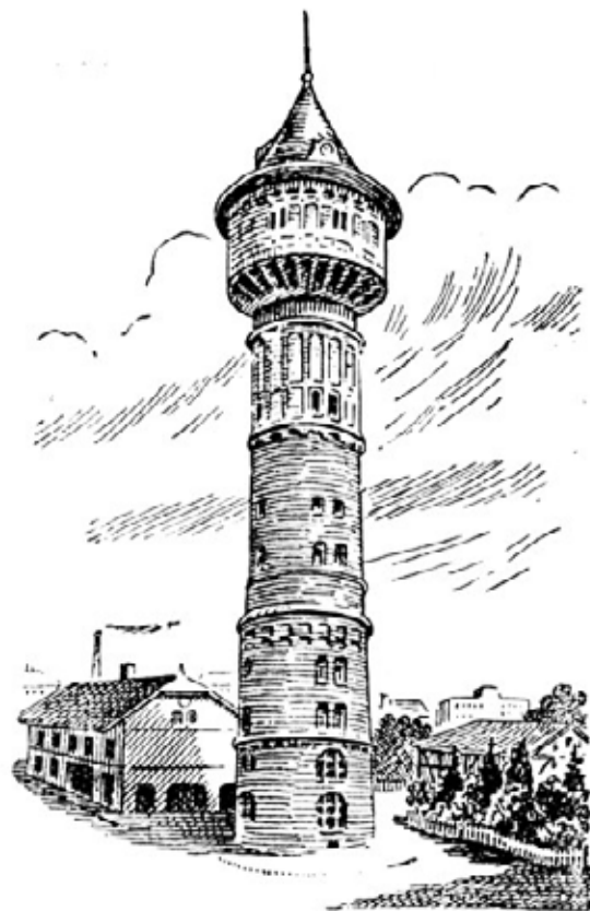
Фиг. 152. Водонапорная башня.
